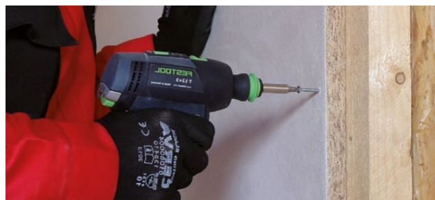
Bild Nr. 7: Befestigung mithilfe von Holzschrauben.
