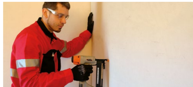
Bild Nr. 6: Verklammern von Platten.
